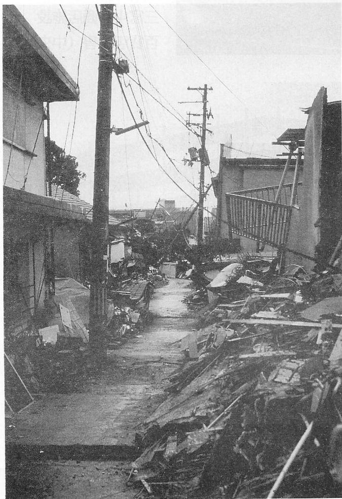
(写真5) 倒壊住宅、インフラ破損による生活道路のマヒ (東灘区)
