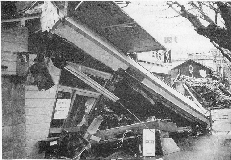
(写真2) 開口部が広くされた 店舗付き住宅 (東灘区)
