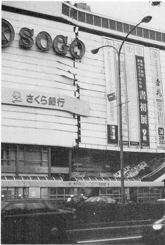
(写真6) 三宮中心商店施設 百貨店被害 (中央区)
