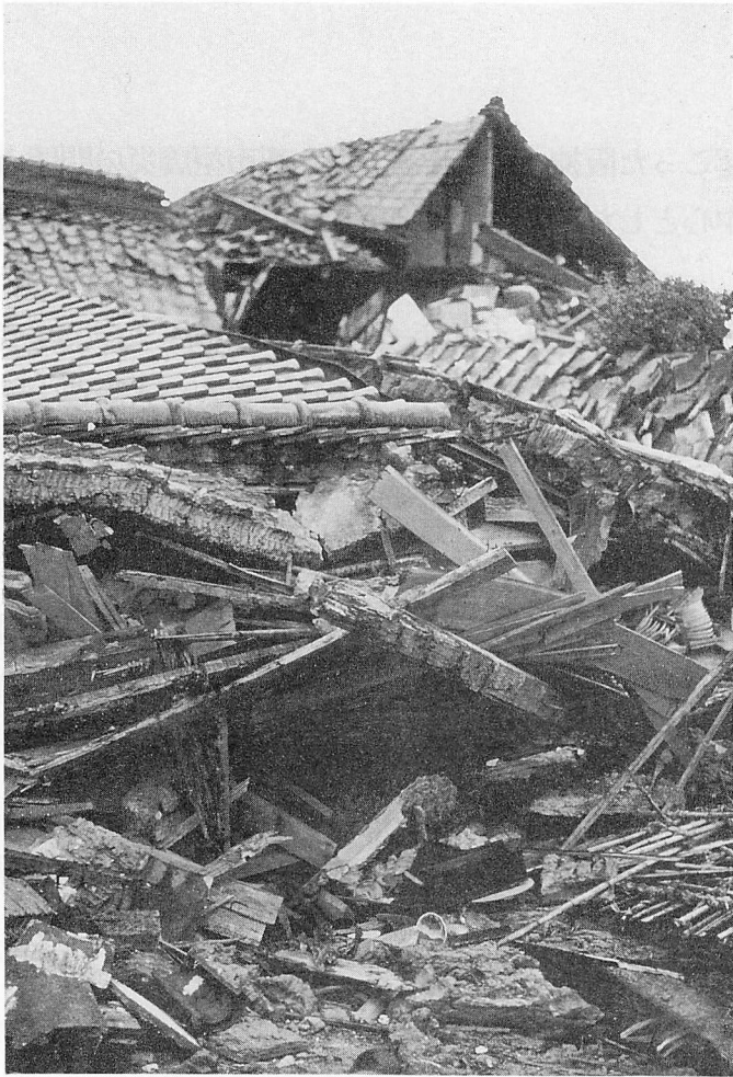
(写真1) 屋根に土を乗せた在来 工法の住宅 (東灘区)
