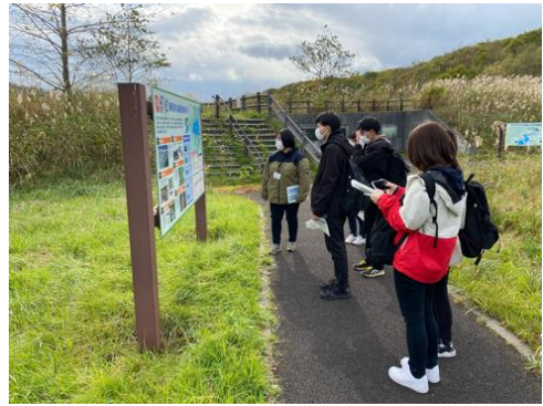
■ 地域資源を生かした体験①-魚道
